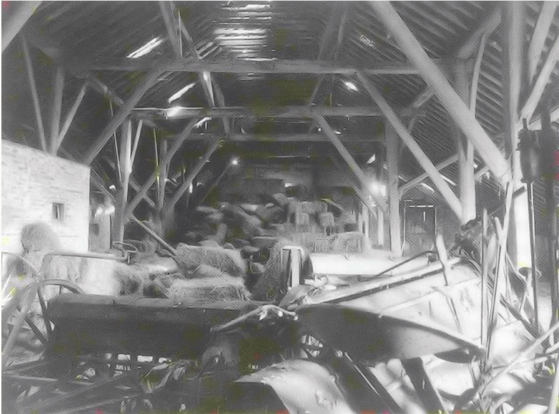
(afb. 14) Overzicht bedrijfsgedeelte naar het oosten in 1974, met aan de rechterzijde zichtbaar een van de twee teruggeplaatste gebintstijlen ten behoeve van de kegeldors
