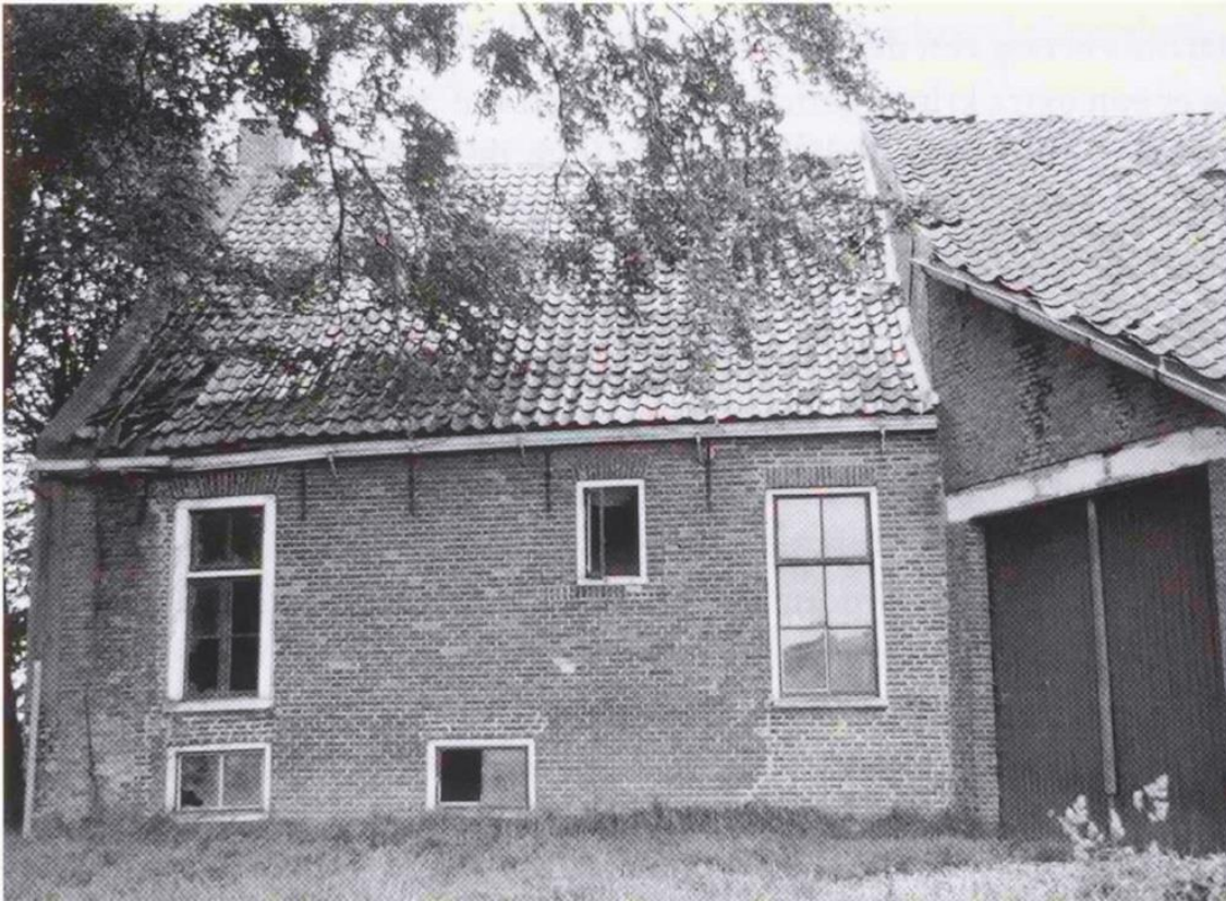
(Afb. 20) Zuidgevel voorhuis in 1972 met het weer opengebroken spekraampje in de opkamer en met de schuine deel deur uit 1951.
