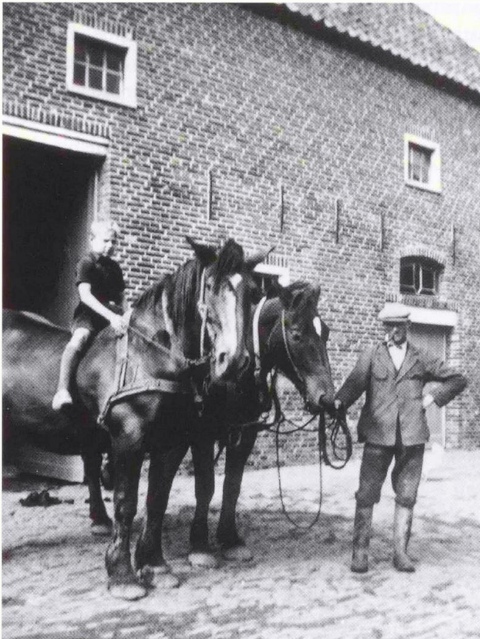
(afb. 12) De Groningse werkpaarden voor de achtergevel in 1941, met de deeldeuren nog in de oorspronkelijke toestand
